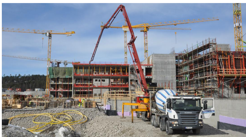
Bygging av Østfold sykehus
